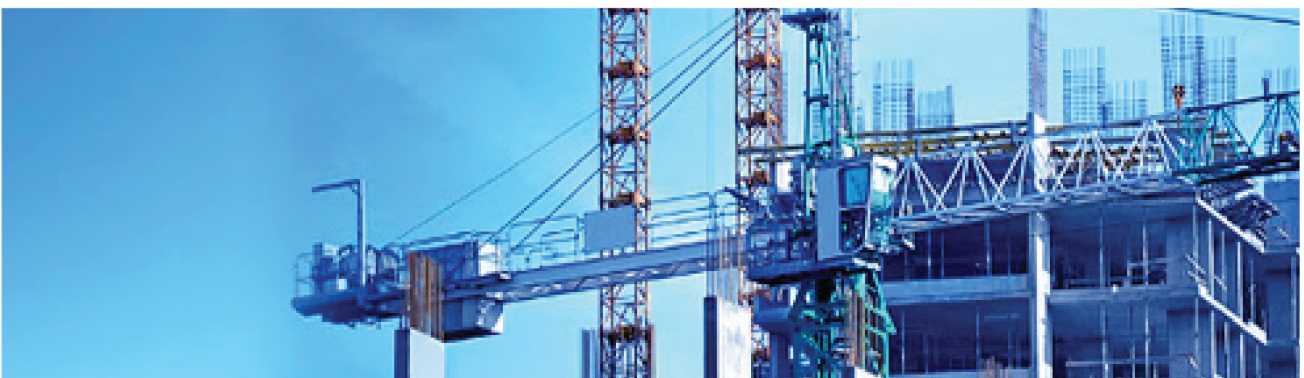
Bụi từ các công trường xây dựng
